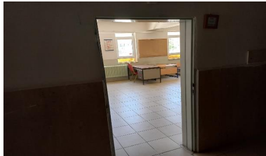
Fotoğraf:İç kapı kanadı montajı yapılacak yer
